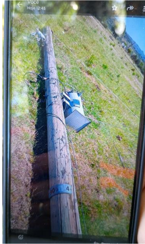
Figura 32 - Evidência de Campo da Central, Região de Caçapava do Sul - Fonte: RGE
