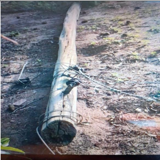
Figura 81 - Evidência de Campo Pampas, Município Santana do livramento - Fonte: RGE
