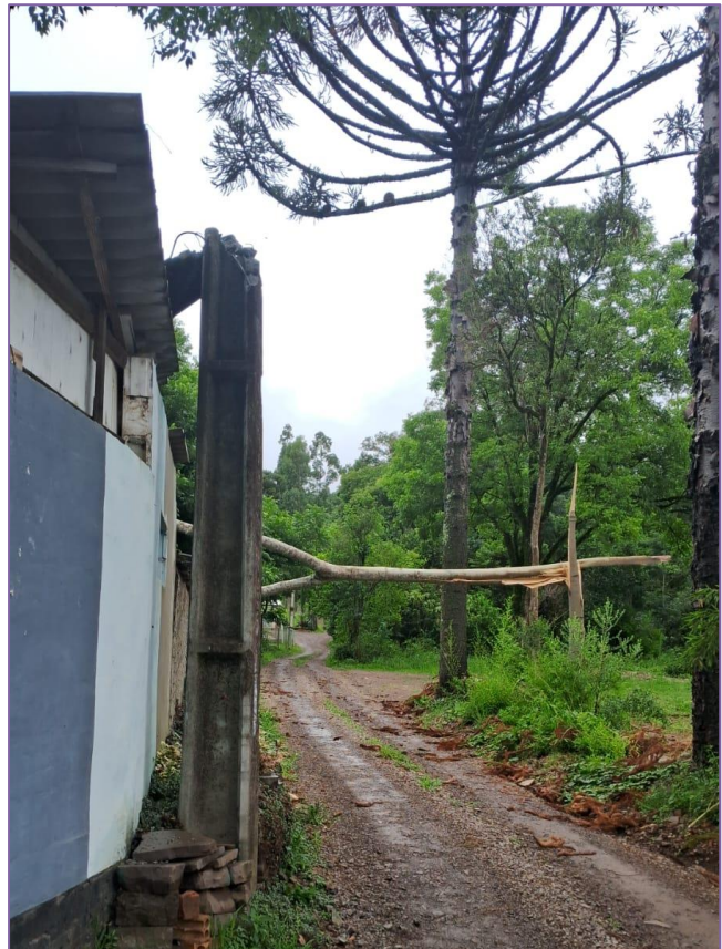
Figura 66 - Evidência de Campo Planalto, Município Nova Prata - Fonte: RGE
