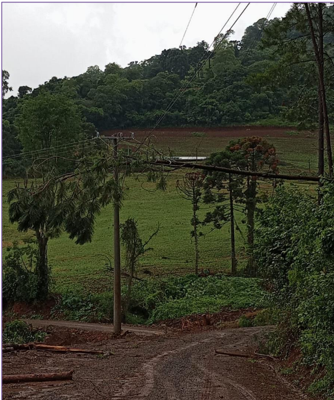
Figura 73 - Evidência de Campo Planalto, Município Guaporé - Fonte: RGE
