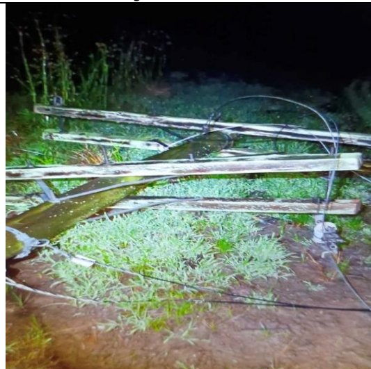
Figura 90 - Evidência de Campo Pampas, Município Santana do Livramento - Fonte: RGE
