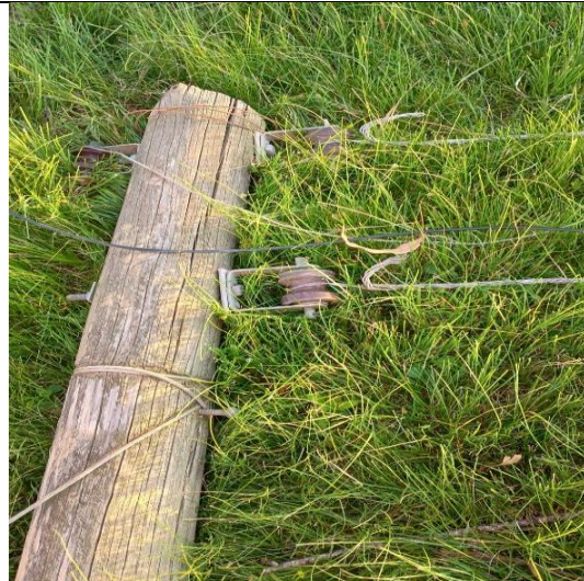
Figura 78 - Evidência de Campo Pampas, Município Santana do livramento - Fonte: RGE
