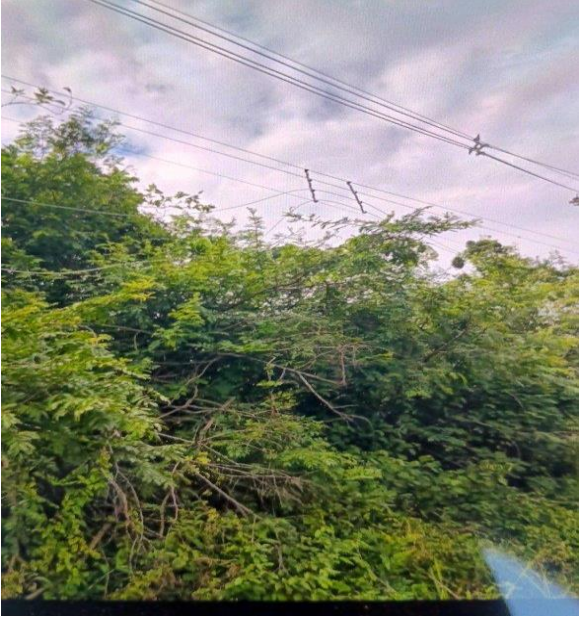
Figura 63 - Evidência de Campo Canoas – Município Gravataí - Fonte: RGE
