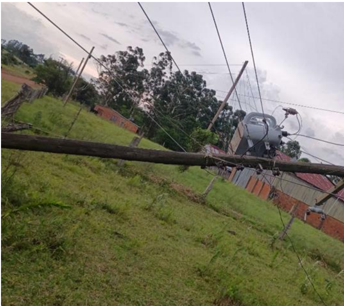
Figura 33 - Evidência de Campo da Central, Região de Caçapava do Sul - Fonte: RGE
