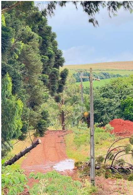
Figura 45 - Evidência de Campo de Planalto, Região de Lagoa Vermelha - Fonte: RGE
