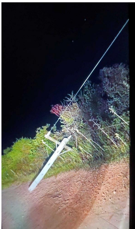
Figura 37 - Evidência de Campo da Central, Região de Caçapava do Sul - Fonte: RGE
