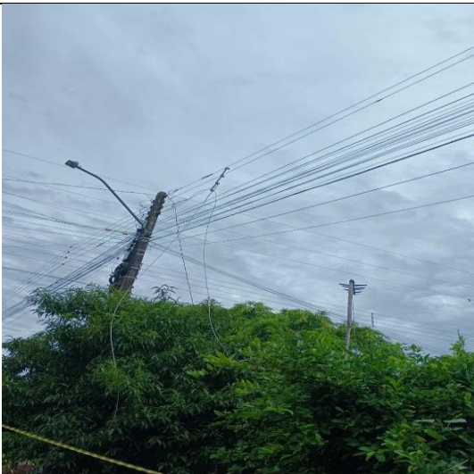
Figura 89 - Evidência de Campo Missões, Município Santiago - Fonte: RGE
