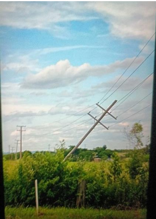
Figura 29 - Evidência de Campo da Central, Região de Caçapava do Sul - Fonte: RGE
