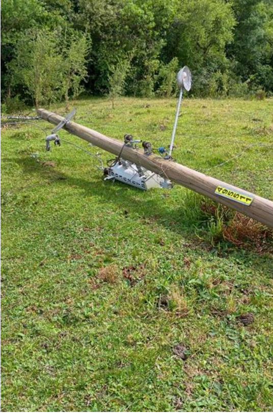
Figura 31 - Evidência de Campo da Central, Região de Caçapava do Sul - Fonte: RGE
