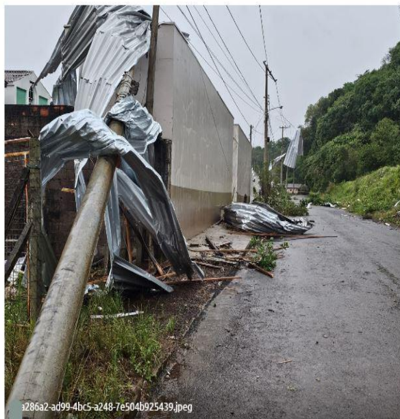
Figura 19- Evidência de Campo do Planalto, Município de Erechim - Fonte: RGE
