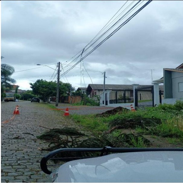
Figura 38 - Evidência de Campo Serra, Município de Caxias do Sul - Fonte: RGE
