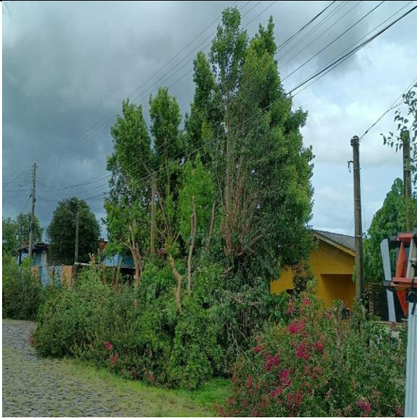
Figura 58- Evidência de Campo Vale dos Sinos, Município de Parobé - Fonte: RGE
