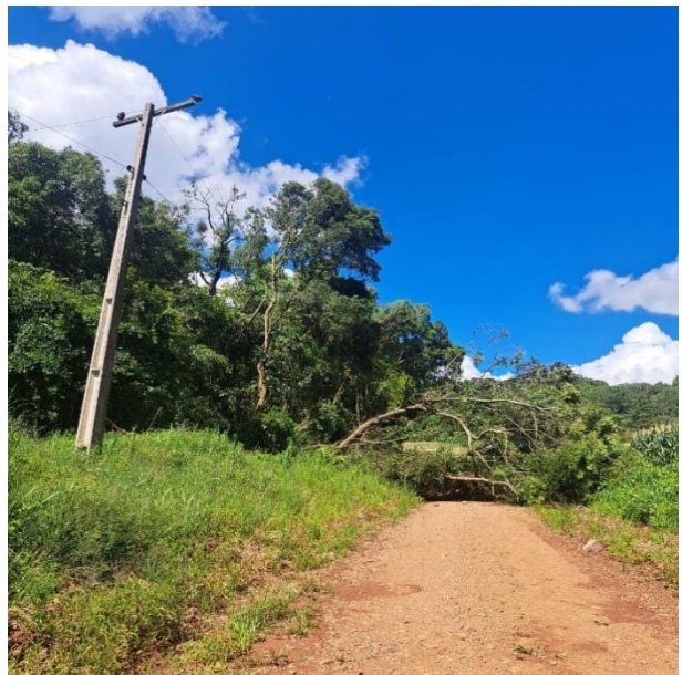
Figura 25- Evidência de Campo Planalto, Município de São José do Ouro - Fonte: RGE
