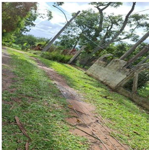
Figura 37 - Evidência de Campo Canoas, Município de Gravataí - Fonte: RGE
