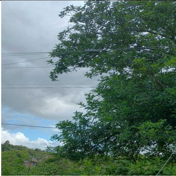
Figura 50- Evidência de Campo Canoas, Município de Gravataí - Fonte: RGE
