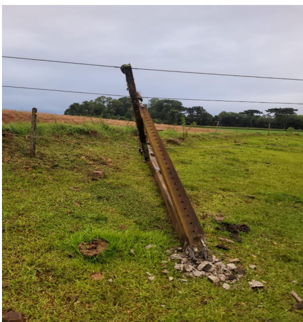
Figura 20 - Evidência de Campo Planalto, Município de São José do Ouro - Fonte: RGE
