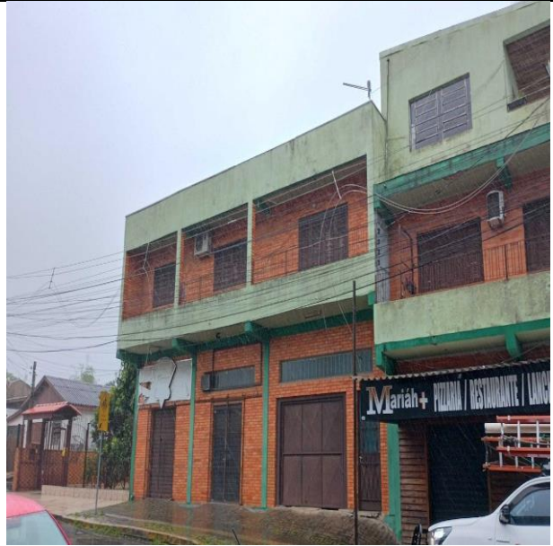
Figura 47- Evidência de Campo Gravataí, Município de Canoas - Fonte: RGE
