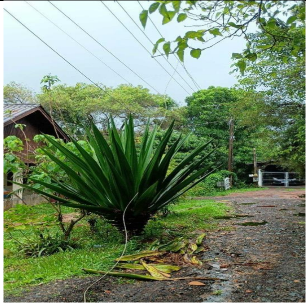
Figura 51 - Evidência de Campo Canoas, Município de Gravataí - Fonte: RGE
