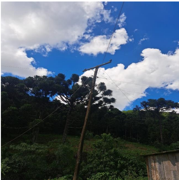
Figura 24- Evidência de Campo Planalto, Município de São José do Ouro - Fonte: RGE
