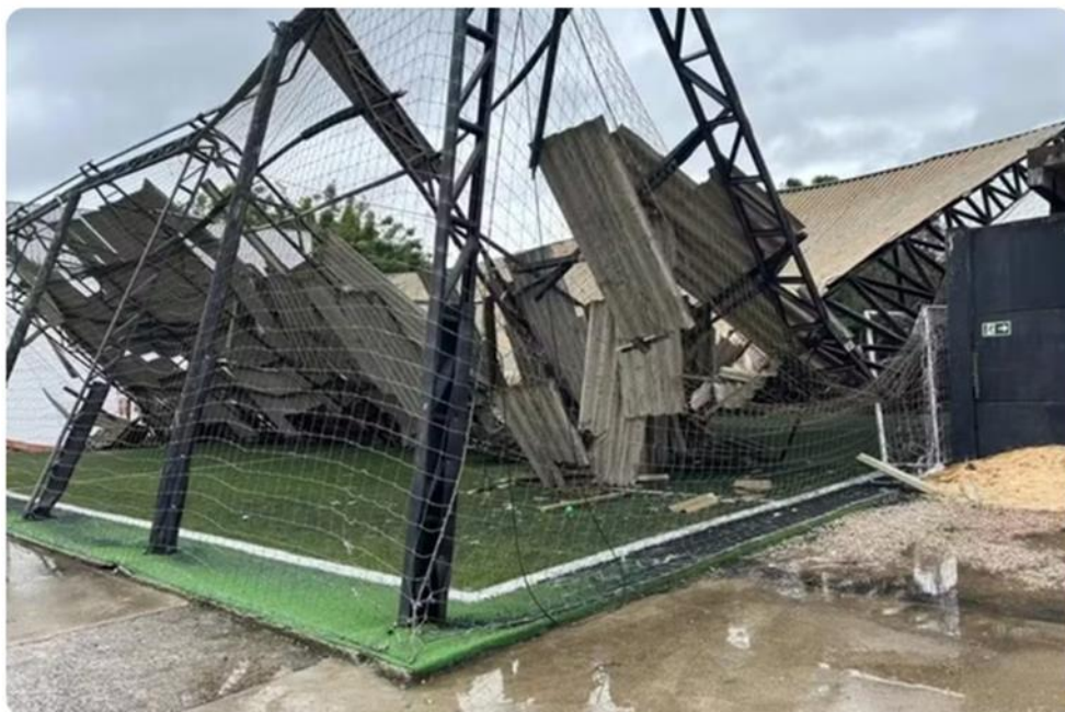
Cobertura de quadra esportiva foi destruída pela força do vento em Butiá — Foto: Corpo de Bombeiros de Butiá/Divulgação
